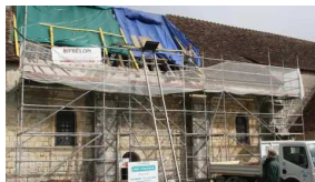
Une nouvelle charpente pour l'église
